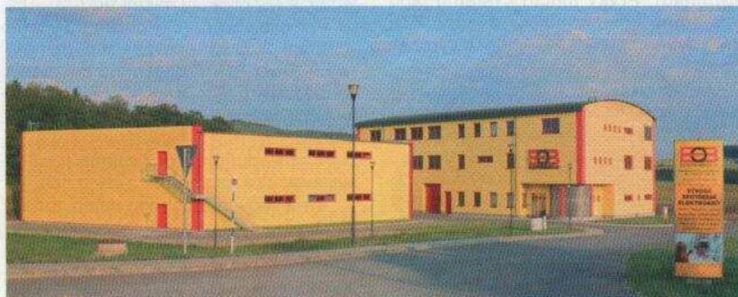
Nové sídlo firmy ELEKTROBOCK
